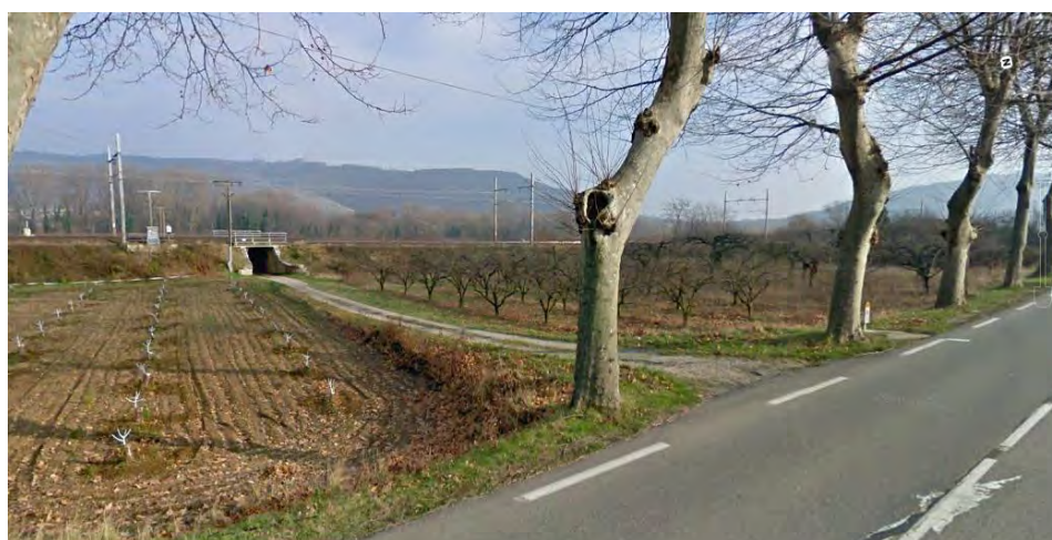
Figure 43 : zone de raccordement avec la RD86 et ouvrage existant sous la voie ferrée
