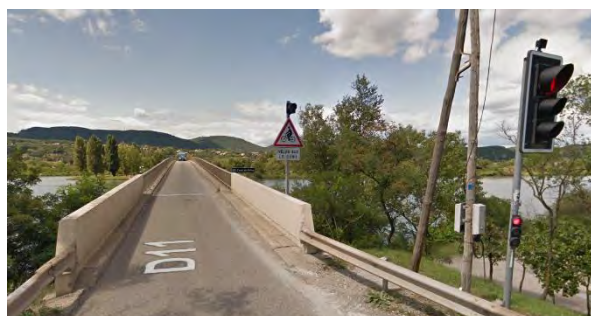
Vue du pont de Charmes (Google Maps)
